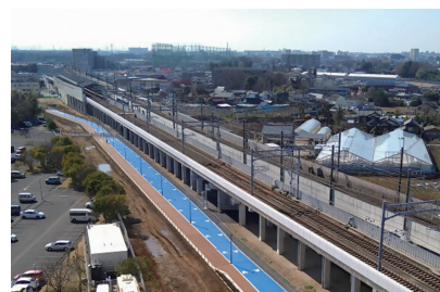
公園予定地 (整備された自転車歩行者専用道路の左横)
