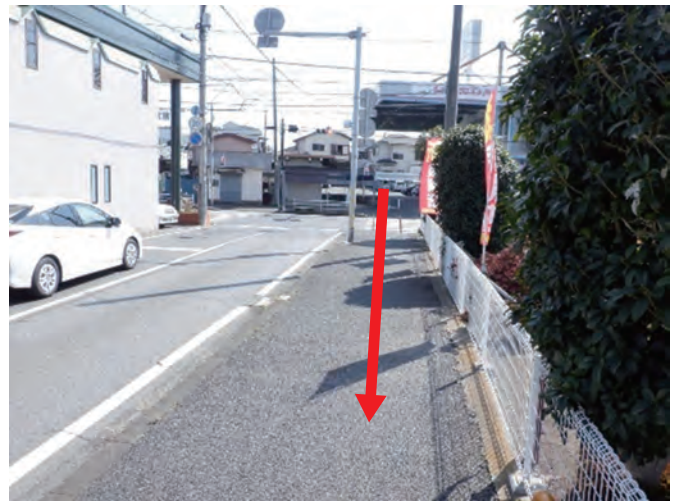
直径60cmの雨水排水管を新たに、もう1ルート埋設します。
