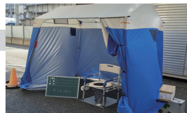
順次設置を進めるマンホールトイレ
